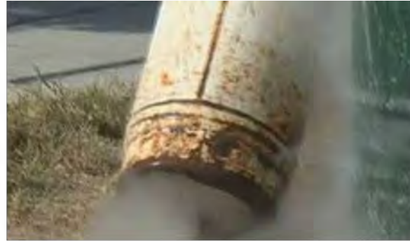
Instalaciones de Gas LP
